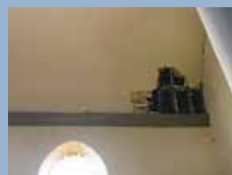
En détails Des travaux à l'église
